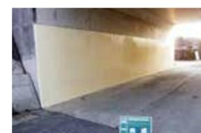
無機質の被膜は有機汚染物質との相溶性がありません。排気ガスによる汚れは勿論、ラッカーズプレー等による落書きに対しても被膜と汚れの一体化がない為、洗浄が容易です。テリオスコートは土木用防汚材料評価試験 I、II 種合格品です。
