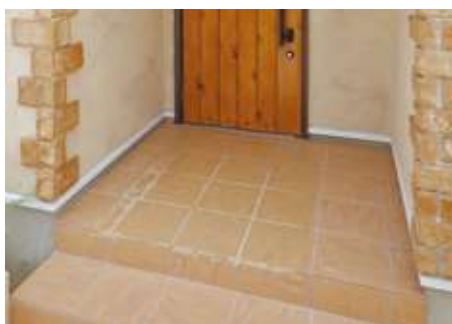
玄関床タイル・目地汚れ防止
