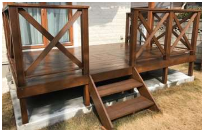
一般住宅の外部ウッドデッキ塗装
