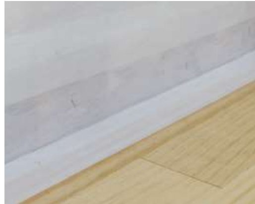
床下の気密処理例
